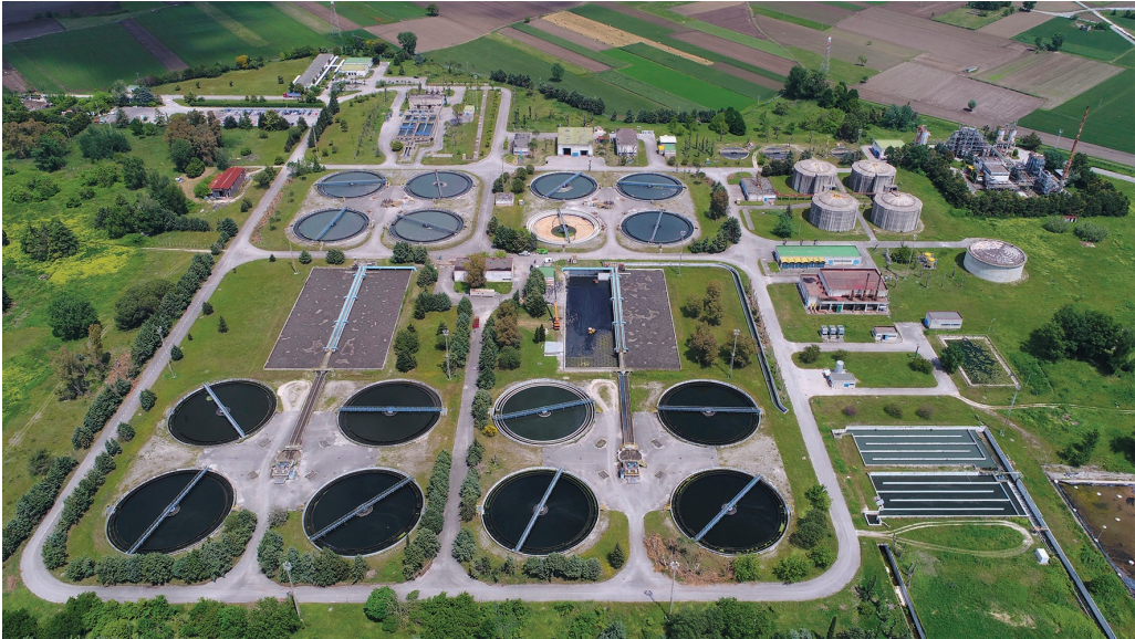
REVAMPING IMPIANTO DI DEPURAZIONE MARCIANISE
